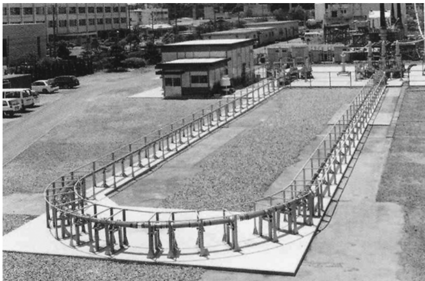
Рис. 16.2. Сверхпроводящий кабель 66 кВ в процессе монтажа (ТЕРСО, Япония)
